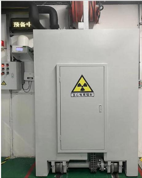
图 4-8 防护门电离辐射警告标志
