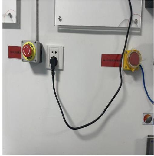
图 4-7 加速器机房急停开关
